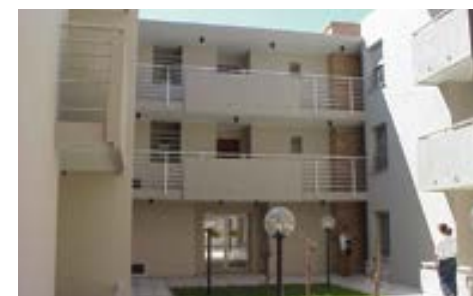
EDIFICIO PARA PACIVOS 2003 / 2.252 MC
