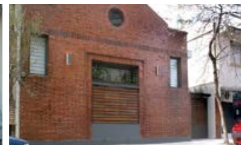
REFORMA LOFT EN POCITOS 2003 / 130 MC
