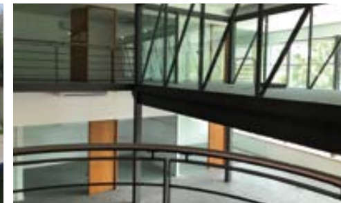
RECONSTRUCCIÓN OFICINAS 2018 / 986 MC
