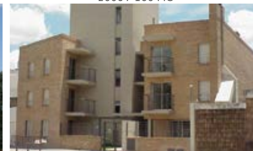
EDIFICIO PARA PACIVOS 2003 / 1.940 MC
