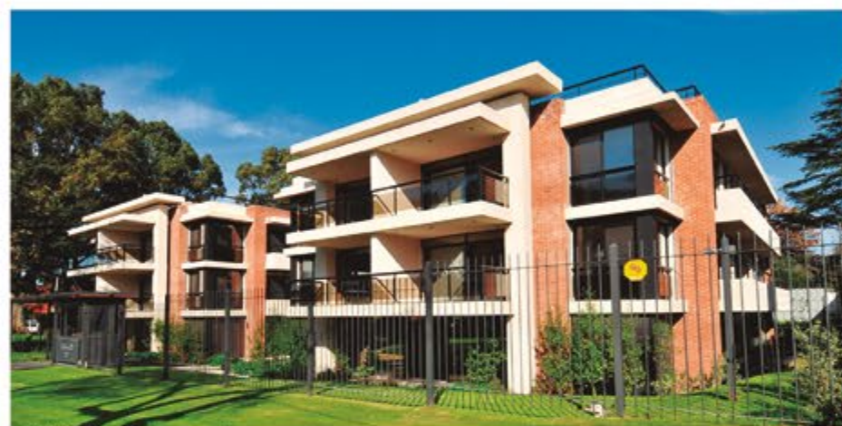
Edificios Jude, Carrasco. Obra nueva.
