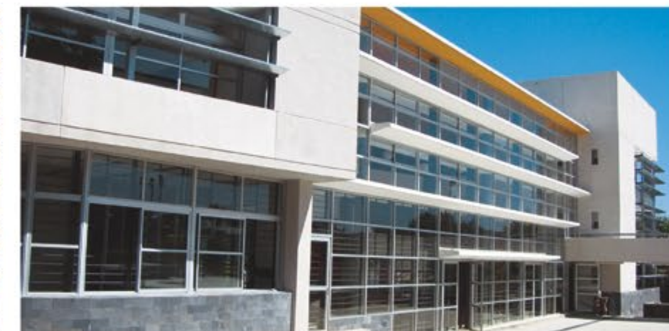
Escuela Barrio Maroñas. Obra nueva.
