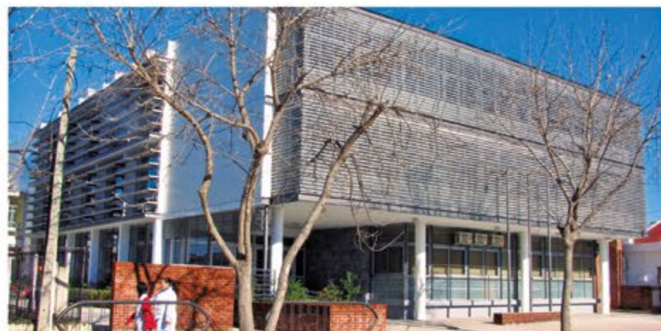
Instituto Formación Docente, Pando, Canelones. Obra nueva.
