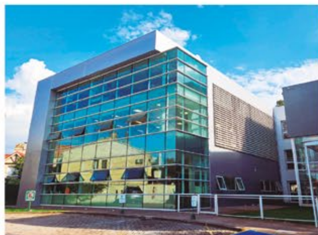
Colegio Alemán, Edificio III - Sede Carrasco - Etapa 1 y 2. Obra nueva.
