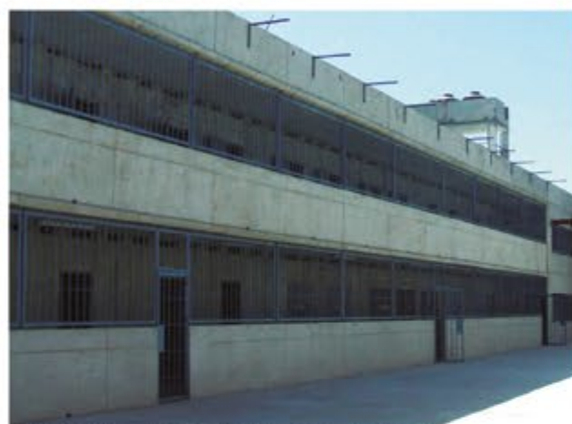
Establecimiento de Reclusión Libertad. Ampliación - Obra nueva.
