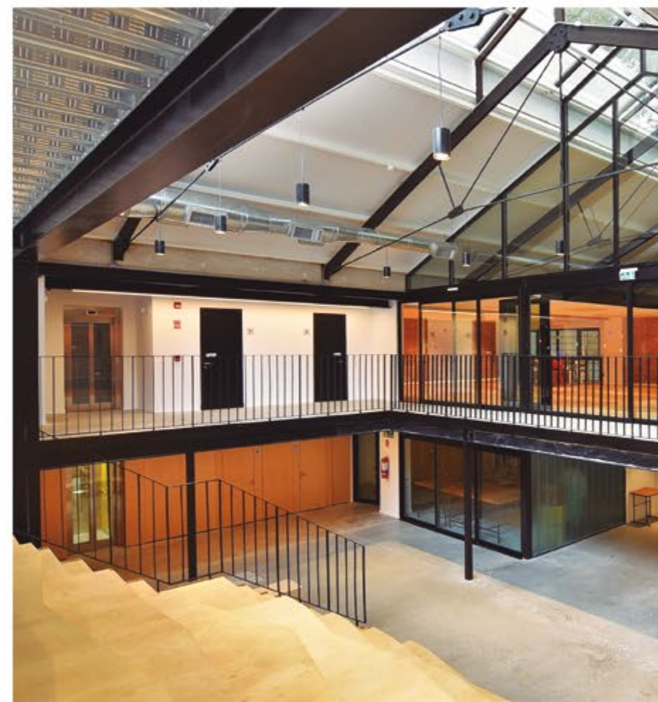
Colegio Seminario - "Edificio Santa Maria Della Strada". Proyecto de Sitio Arquitectura. Obra nueva y reforma.
