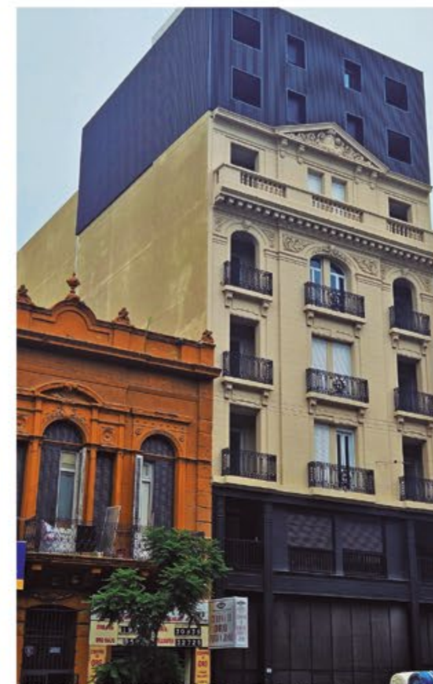
Edificio Uruguay 1005 - MVOT/BPS, Centro de Mdeo. Obra nueva.
