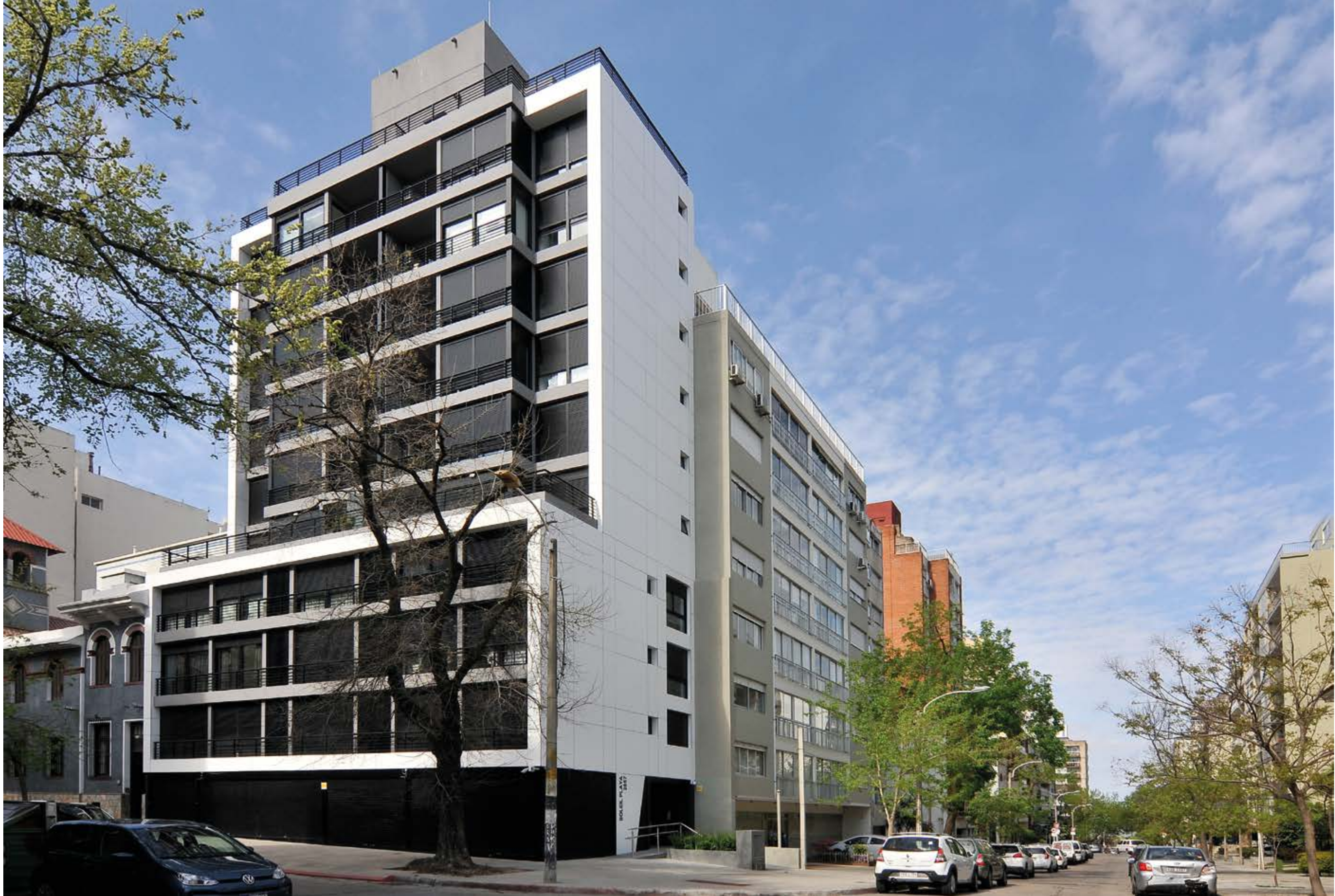
PROYECTO Y DIRECCIÓN: ESTUDIO ATIJAS ANTEPROYECTO: ATIJAS CASAL ARQUITECTOS GERENCIAMIENTO DE OBRA : ING. JORGE BZUROVSKI PROGRAMA: RESIDENCIAL UBICACIÓN: POCITOS, MONTEVIDEO ÁREA CONTRUÍDA: 1.500 M2 AÑO: 2018 FOTOGRAFÍA: JOSÉ PAMPÍN
