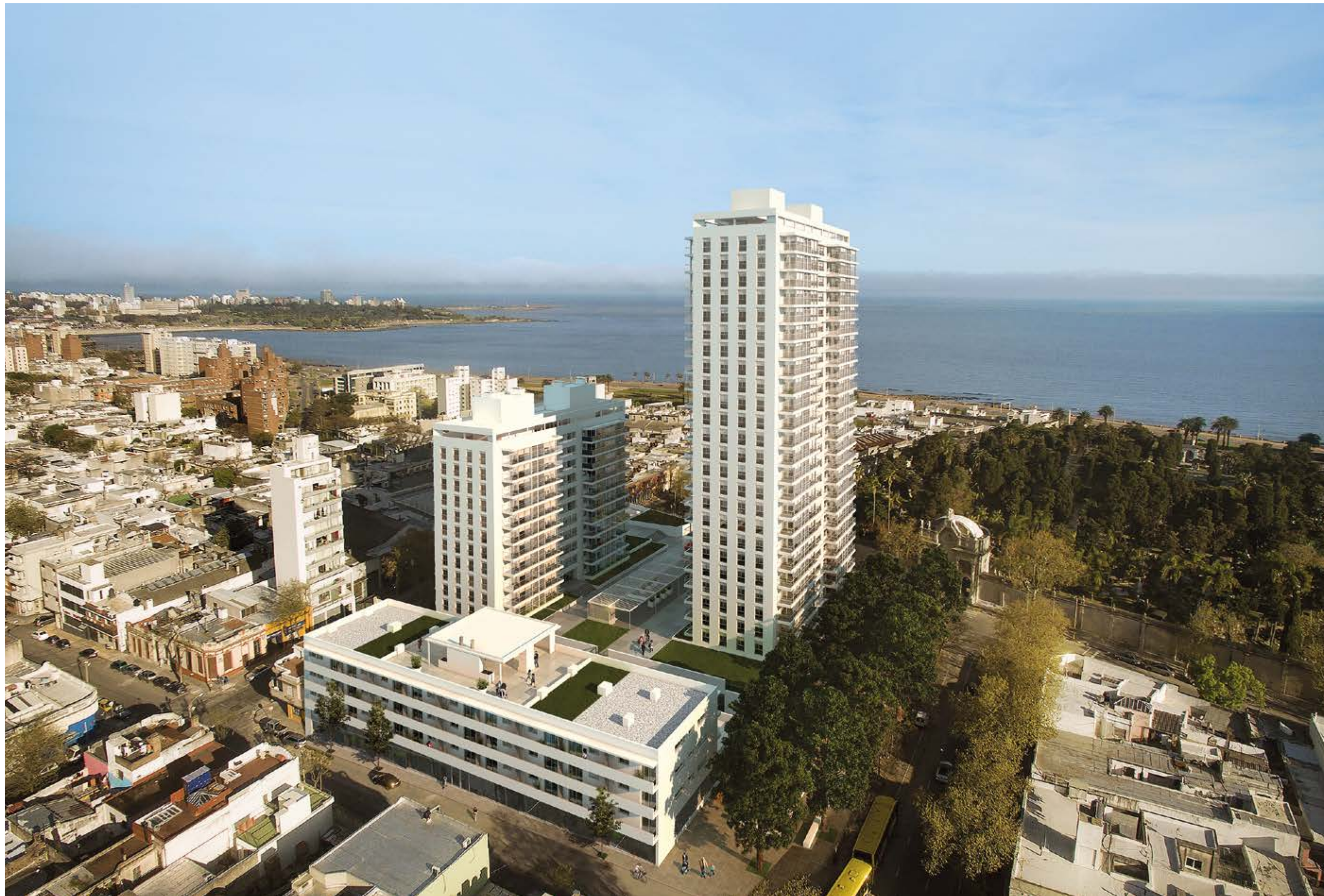
PROGRAMA: RESIDENCIAL UBICACIÓN: BARRIO SUR, MONTEVIDEO METRAJE: 37.000 M2 AÑO: 2015 FOTOGRAFÍA: JOSÉ PAMPÍN, NICO DI TRÁPANI Y CHRISTOFF+DE SIERRA ARQUITECTOS
