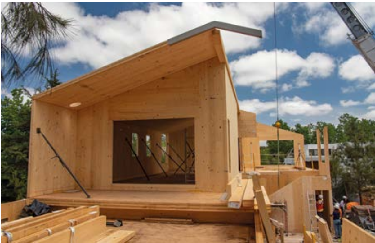
Obra en construcción con la técnica Mass Timber
