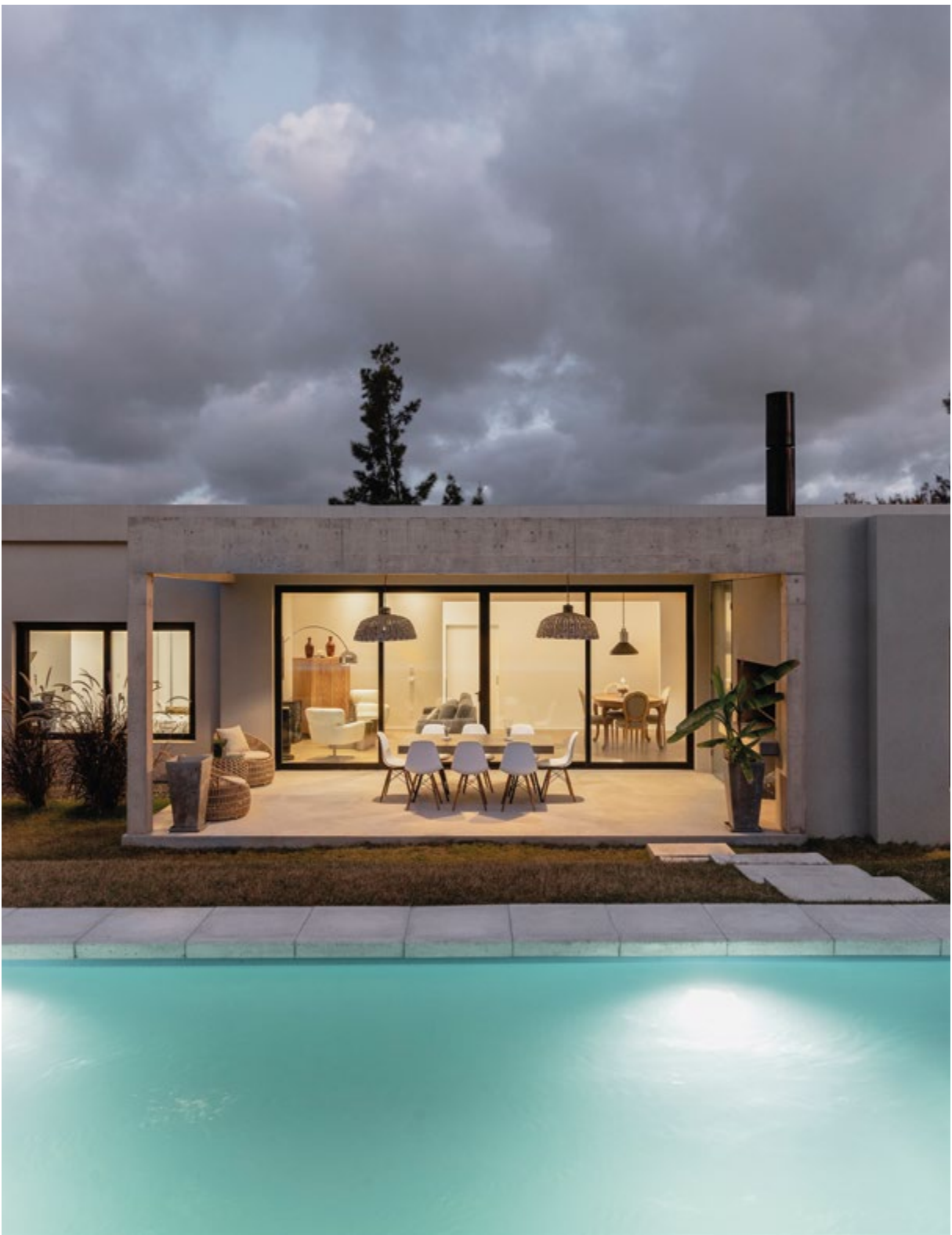
La piscina se agregó al proyecto casi terminando la obra y se tuvo que colocar en esa altura para frenar el escurrimiento del agua, pero básicamente debido a las complejidades presentadas por el terreno, con mucha piedra y esa circunstancia presentó dificultades al momento de estudiar la instalación.
