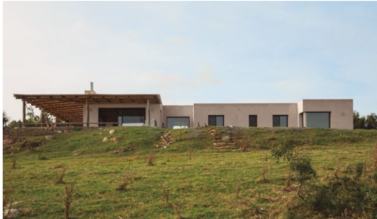
La casa se proyectó en el punto más alto del terreno, con vistas inmejorables en un entorno paisaje natural en Edén. La planta principal en forma de H logra armonizar la distribución de espacios haciendo que los ambientes privados se encuentren en las distintas alas laterales de la casa y, en el centro los ambientes de uso común.
