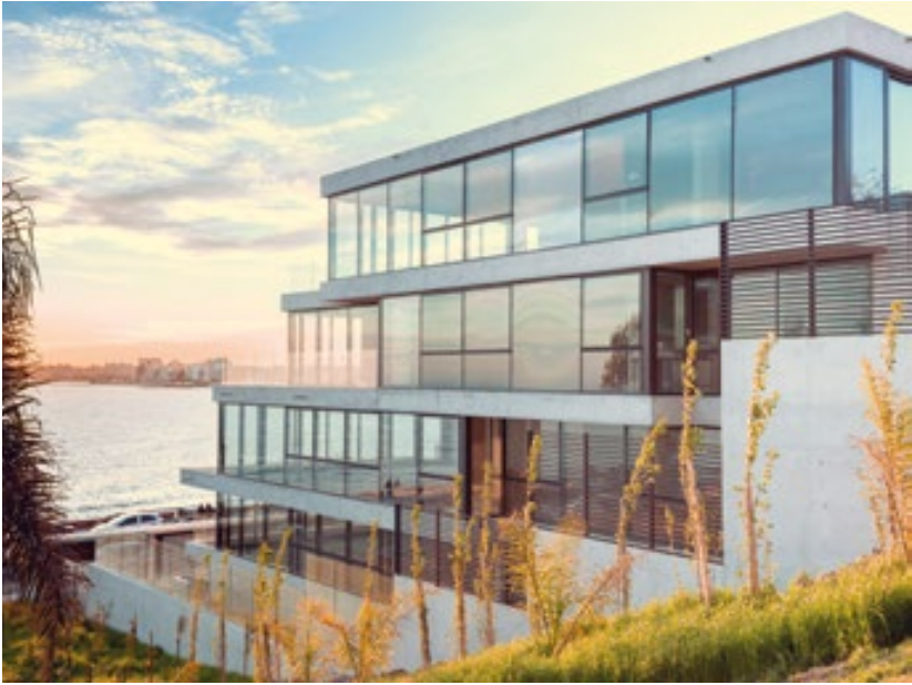
5529 RAMBLA Arquitectura Arq. Francesco Comerci DVH compuesto por: Sunergy Clear 6 mm. + cámara de 12 mm. + cristal incoloro 6 mm.
