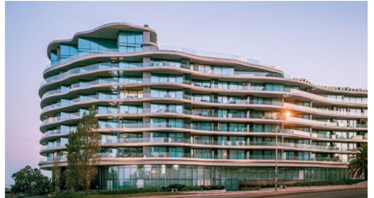
FORUM Arquitectura Arq. Carlos Ponce de León & Arq. Carlos Ott DVH compuestos por: Cool Lite SKN 154 8 mm. templado + cámara de 12 mm. con perfiles color negro + cristal laminado incoloro 4.4.2
