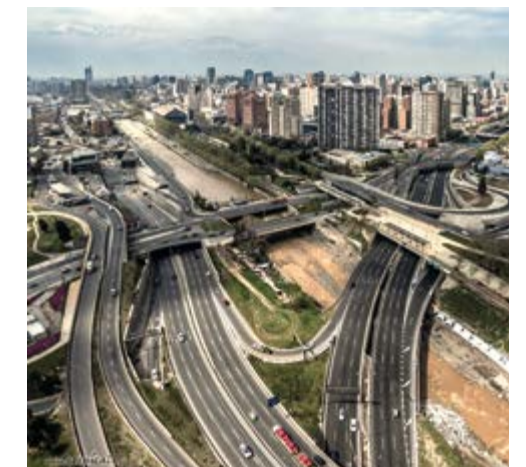
FIG.2. AUTOPISTA CENTRAL Y COSTANERA NORTE SOBRE EL RÍO MAPOCHO, SANTIAGO DE CHILE, 2006
