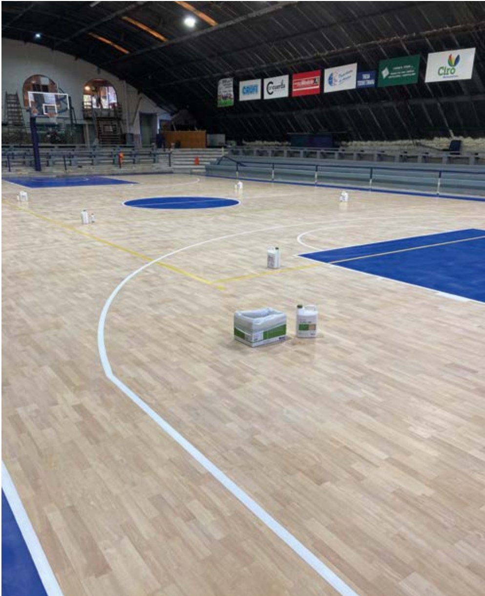
Piso deportivo FIBA en el Palacio Peñarol Fecha de la obra: Mes de Octubre 2023. Se instaló el piso deportivo modelo Compac 45 de Dalla Riva, homologado FIBA “Partner” nivel 1 y certificado EN 14904 clase mínima A4. Piso premium para la alta competencia deportiva sin afectar la salud de los deportistas y que potencia el rendimiento. Compac 45 consta de un sistema compuesto de madera maciza de Hebea de 140 kg/m3 de densidad. La madera de Hevea tiene la propiedad de ser elástica, siendo la madera idónea para el uso deportivo porque asegura el rebote de la pelota uniformemente.
