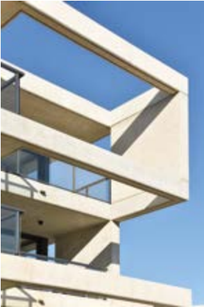
TAPA EDIFICIO OXO GREEN FOTO JOSÉ PAMPÍN
