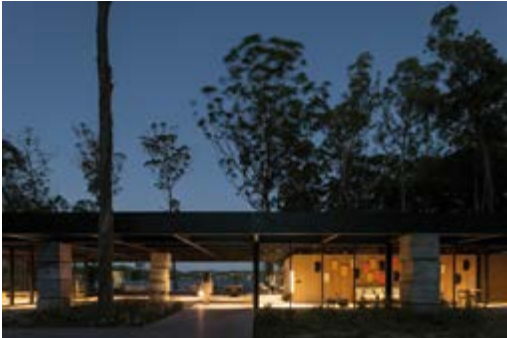
TAPA OBRA RESERVA MONTOYA FOTO LEONARDO FINOTTI
