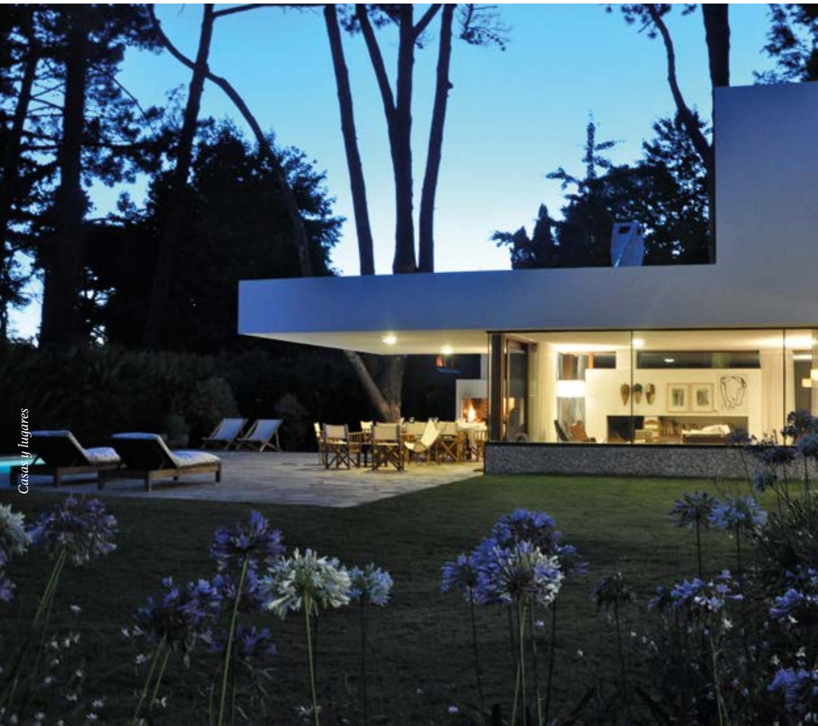
La construcción es tan sencilla como el programa. La casa fue construida en cinco meses con muros portantes de ladrillos cerámicos y losas de hormigón armado enteramente cubiertas por un revoque a la cal. La única particularidad es el voladizo posterior que se apoya en refuerzos metálicos ocultos en la carpintería. Las puertas y ventanas son de carpintería de madera. Los marcos y celosías exteriores de lapacho y el resto de cedro.
