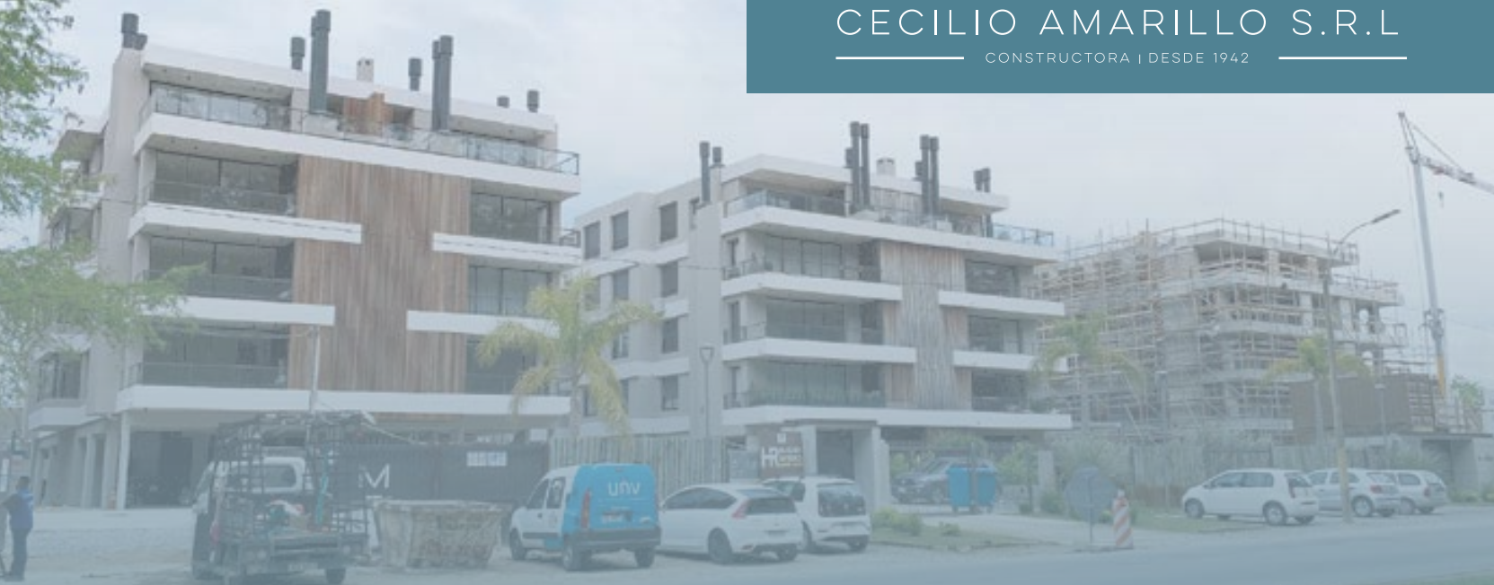
PARQUE MADERO | EN OBRA
