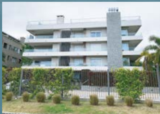
EDIFICIO LAS CONDES | 2018
